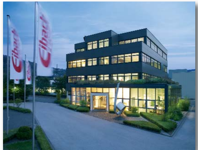
Firmengebäude der Heinrich Eibach GmbH in Finnentrop
