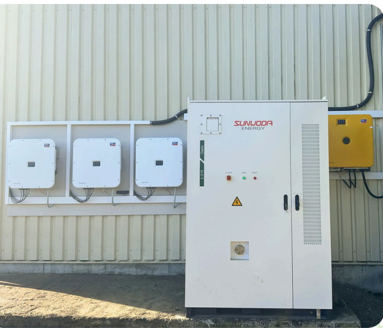
Kombination aus SMA Sunny Island X 50 und Sunwoda Oasis L215 Speicher – leistungsstarkes, skalierbares Outdoor-Energiespeichersystem für Gewerbe- und Industriebetriebe.
