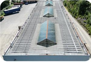
Insgesamt **532 Solarmodule** und vier leistungsstarke Wechselrichter sorgen für einen reibungslosen Betrieb der PV-Anlage, die einen geplanten Jahresertrag von **957,69 kWh pro installiertem kWp** liefert. Diese Eigenproduktion senkt langfristig die energiekosten erheblich und versorgt wesentliche Bereiche wie Beleuchtung, Heizung, Kühlung und weitere elektrische Anwendungen im Unternehmen mit erneuerbarer Energie.
